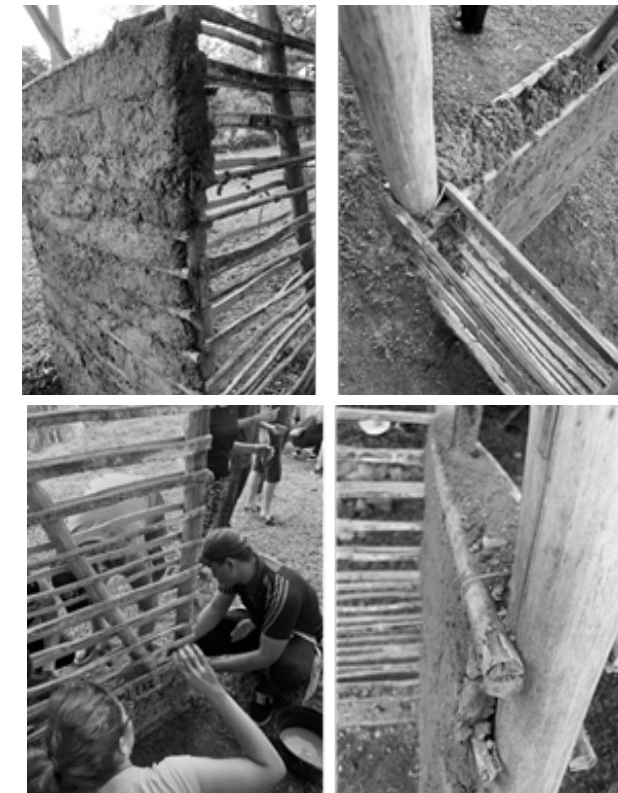
Figura 3. Proceso de levantamiento análogo de la disposición estructural del bahareque.
